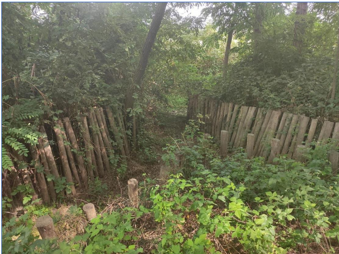
Si tratta di pali in castagno di lunghezza variabile a seconda dei casi (generalmente 2.5 – 3 m) del diametro di 12-16 cm appuntiti da una parte per poter essere infissi mediante battipalo, per una lunghezza di circa 1-1.5 m. I pali vengono posizionati uno accanto all'altro in modo abbastanza serrato, così da avere 5-6 pali per ogni metro di sviluppo dell'opera.
