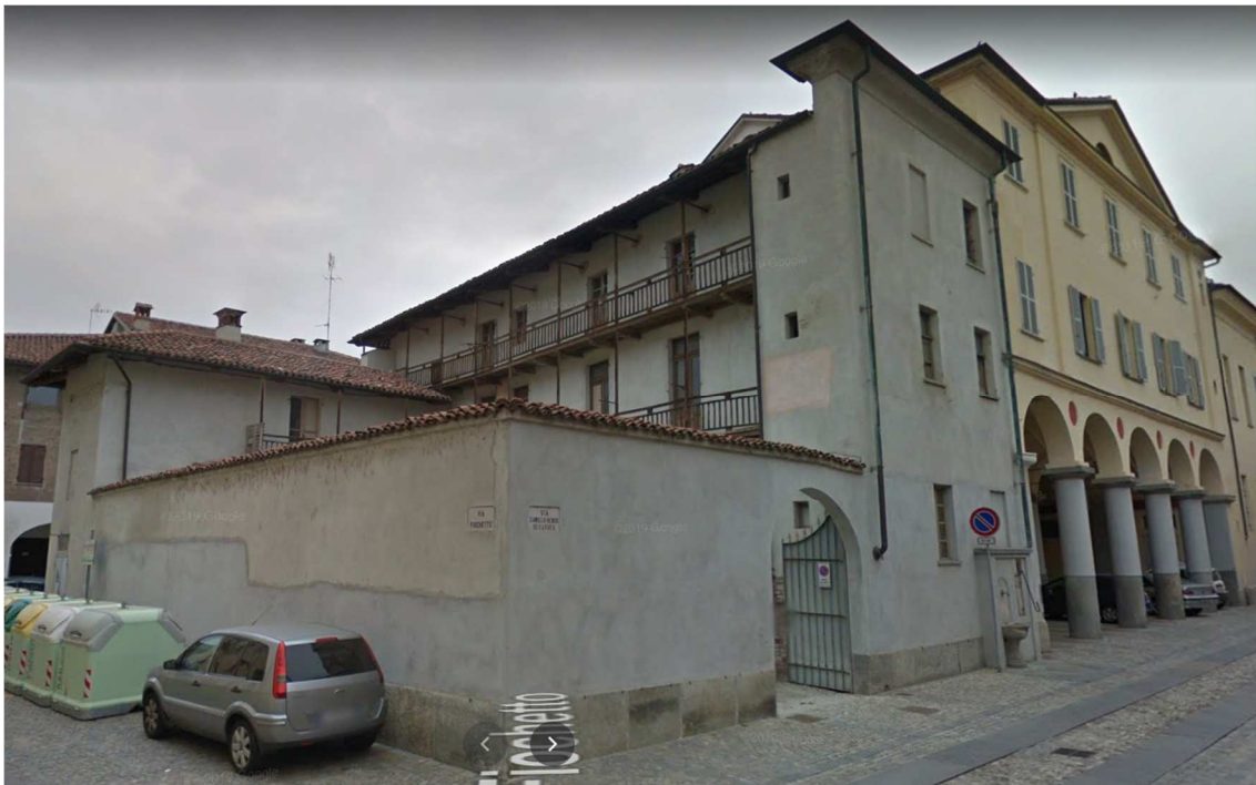
Fotografie del fabbricato comunale oggetto di recupero
